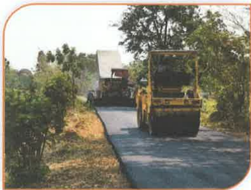
โครงการปรับปรุงซ่อมแซมเสริมผิวจราจรแอสฟัลท์ติกคอนกรีต รหัสทางหลวงท้องถิ่น ชย.ถ. 90-001 เส้นทาง บ้านบัว-บ้านแก่น้อย หมู่ที่ 3 บ้านแก่น้อย
