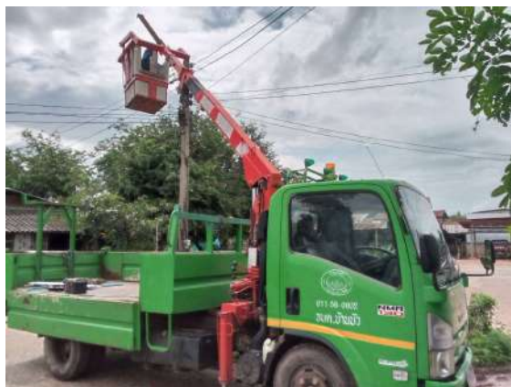
ซ่อมแซมไฟฟ้าส่องสว่างในหมู่บ้าน
