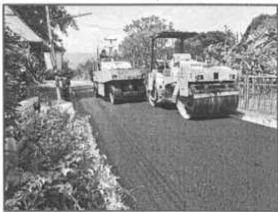
โครงการซ่อมแซมเสริมผิวถนนแอสฟัลต์ติกคอนกรีต(OVERLAY)
