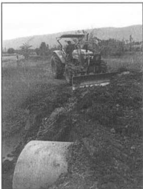
โครงการก่อสร้างฝายดินพร้อมวางท่อ คอนกรีตเสริมเหล็ก
