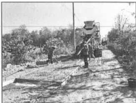
โครงการก่อสร้างถนนคอนกรีตเสริมเหล็ก (เส้นทางบ้านเขาเราสุข)
