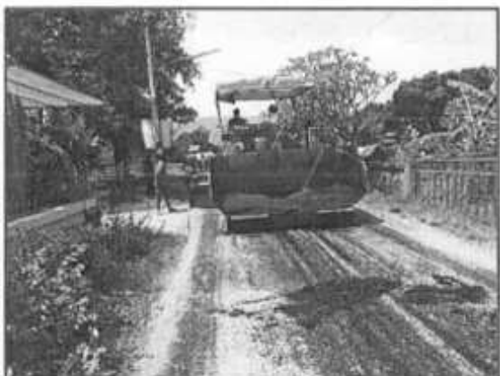
โครงการซ่อมแซมเสริมผิวถนนแอสฟัลต์ติกคอนกรีต(OVERLAY)
