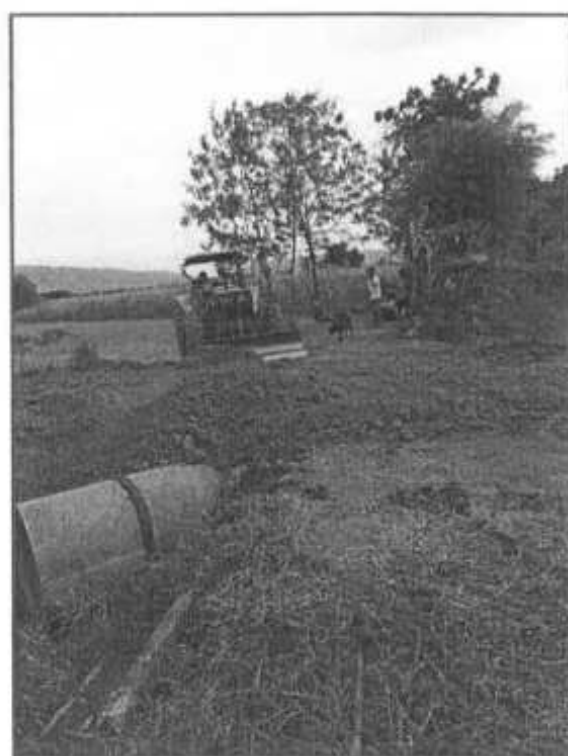
โครงการก่อสร้างฝายดินพร้อมวางท่อ คอนกรีตเสริมเหล็ก
