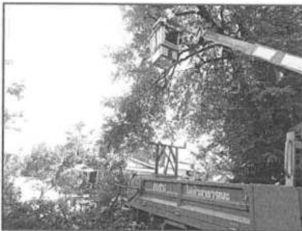
ตัดต้นไม้กิ่งไม้ ที่ใกล้สายไฟ เพื่อป้องกันไฟฟ้าช็อต
